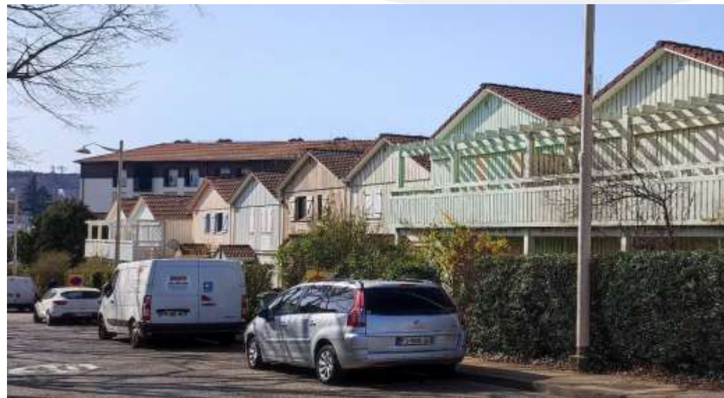
Photo de la rue après intervention
